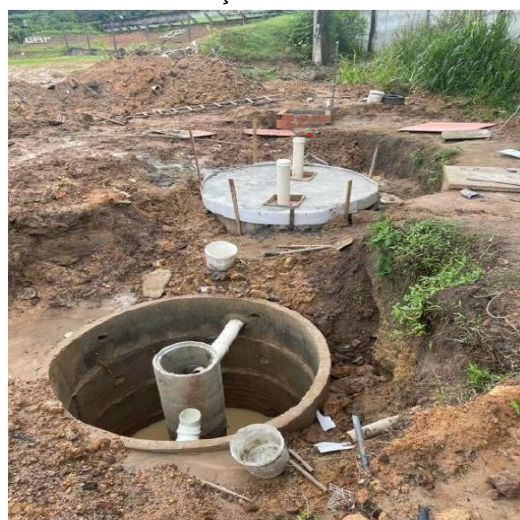
Foto – Instalações hidrossanitárias
