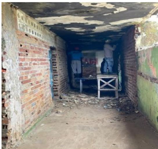
**FOTO 03** - Retirada do reboco das paredes e laje.
